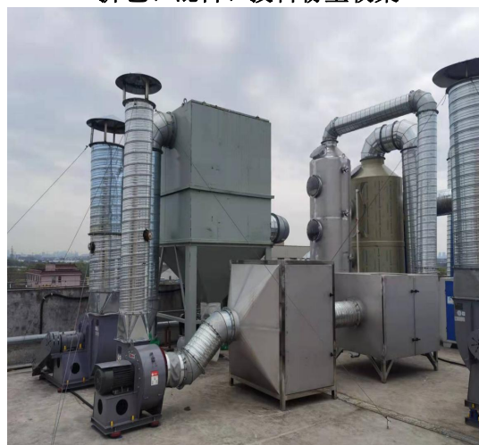
拆包、混料、投料粉尘处理、排放（1 根） 熔融挤出废气处理、排放（1 根）
