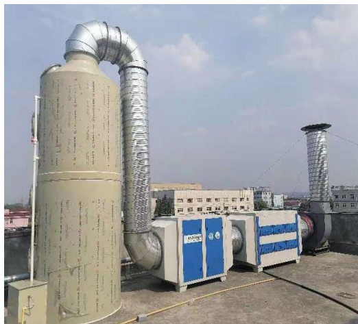
成型废气、熟化废气处理设备
