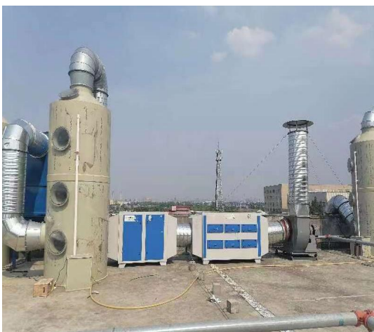
橡胶配料投料粉尘和炼胶废气处理设备
