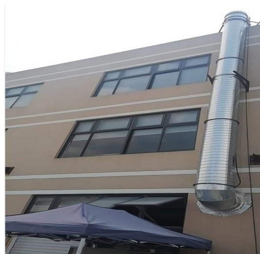
开炼废气收集、上述废气有组织收集
