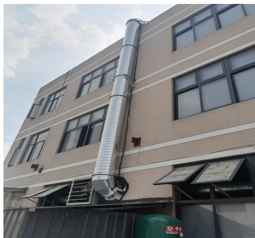
成型废气、熟化废气有组织收集
