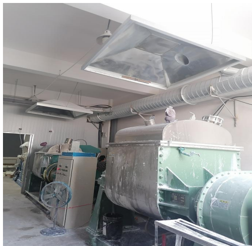
橡胶配料投料粉尘和密炼废气、滤胶机废气收集
